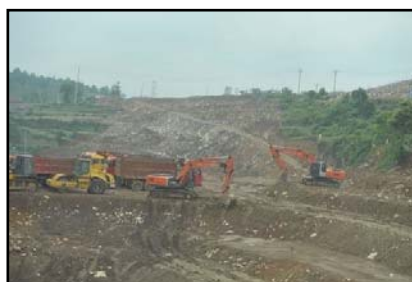
贵龙项目工地现场
